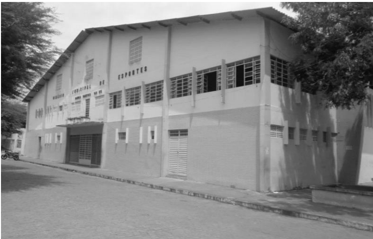
Figura 25 – Fachada do Ginásio de Esportes Paulo Santos Gomes.
