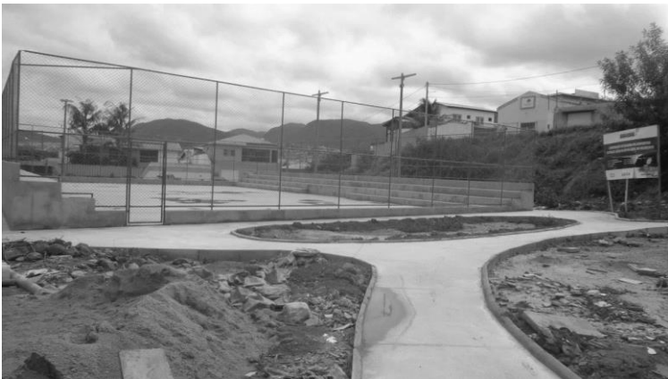
Figura 3 – Quadra poliesportiva em construção no Bairro Mundo Novo.
